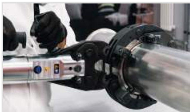
Assemblaggio pressatura n°1 / Press assembly phase 1
